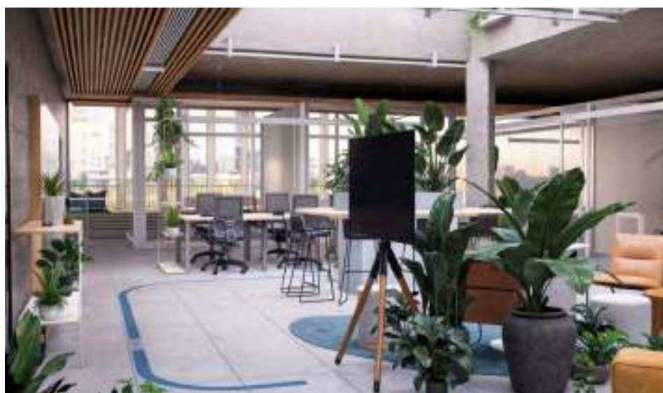
O terceiro andar da Acipi já está em obras para receber a expansão do Inova Acipi
