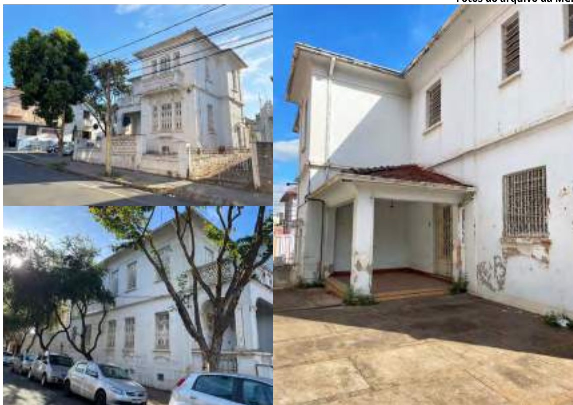
A preservação da estrutura foi uma prioridade do projeto
