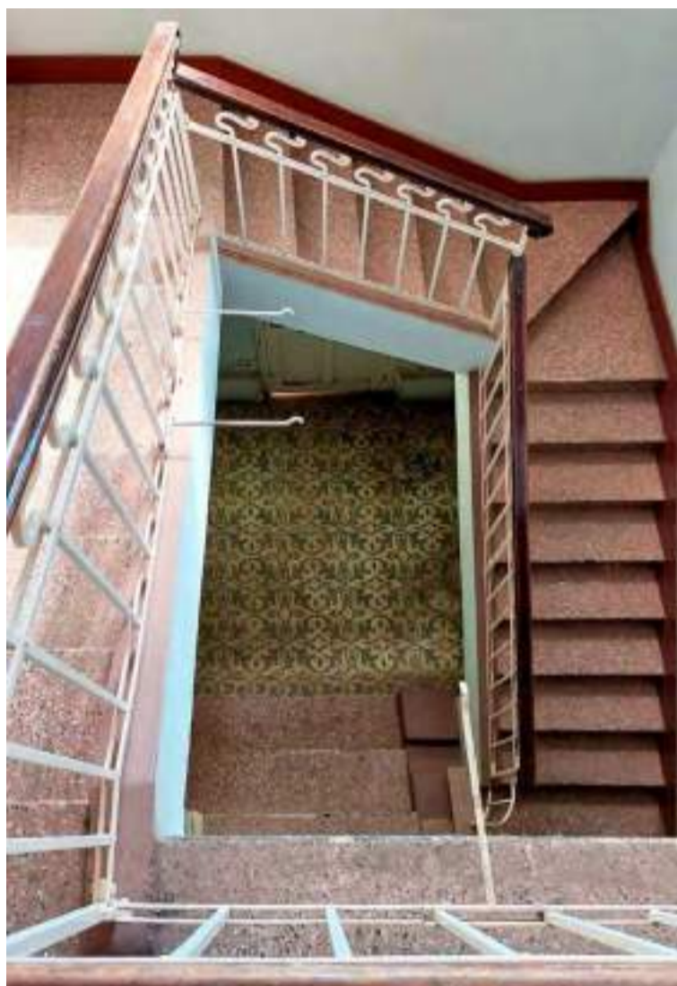
A recuperação dos pisos originais foi outro aspecto fundamental da reforma
