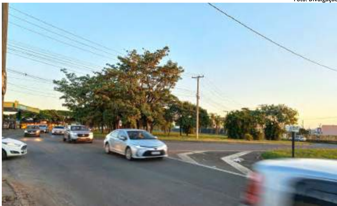
A instalação de sistema com semáforo está autorizada desde 2019, ainda no governo Barjas Negri
