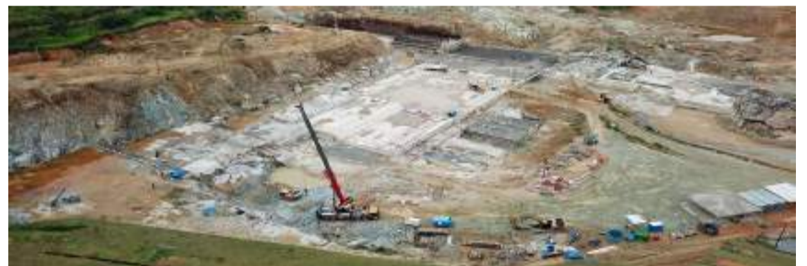
Barragem de Pedreira
