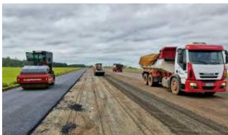
Obra contempla novo pavimento em 36 mil metros quadrados da pista e ampliação da taxiway
