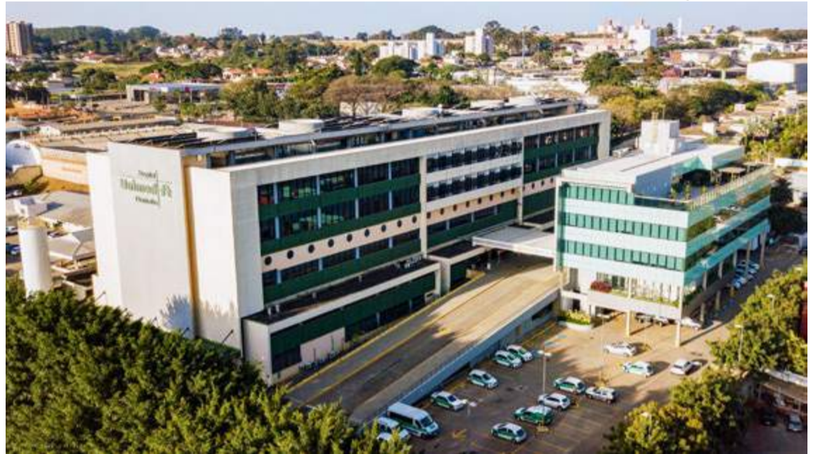
Hospital Unimed Piracicaba e Centro Administrativo da Cooperativa
