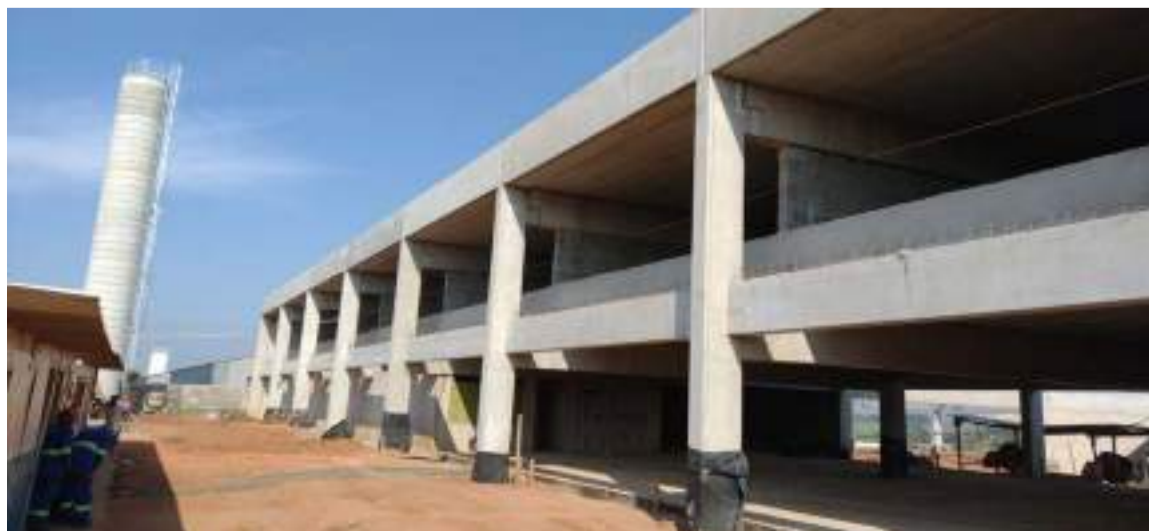
A construção ocupará 3.379,40 m 2 e contará com 12 salas de aula
