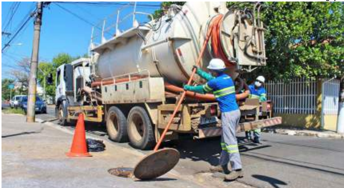
Desobstrução de rede de esgoto causada por excesso de lixo
