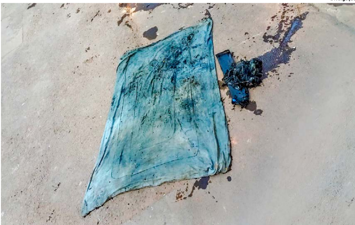
Cobertor retirado de rede de esgoto entupida na última terça-feira
